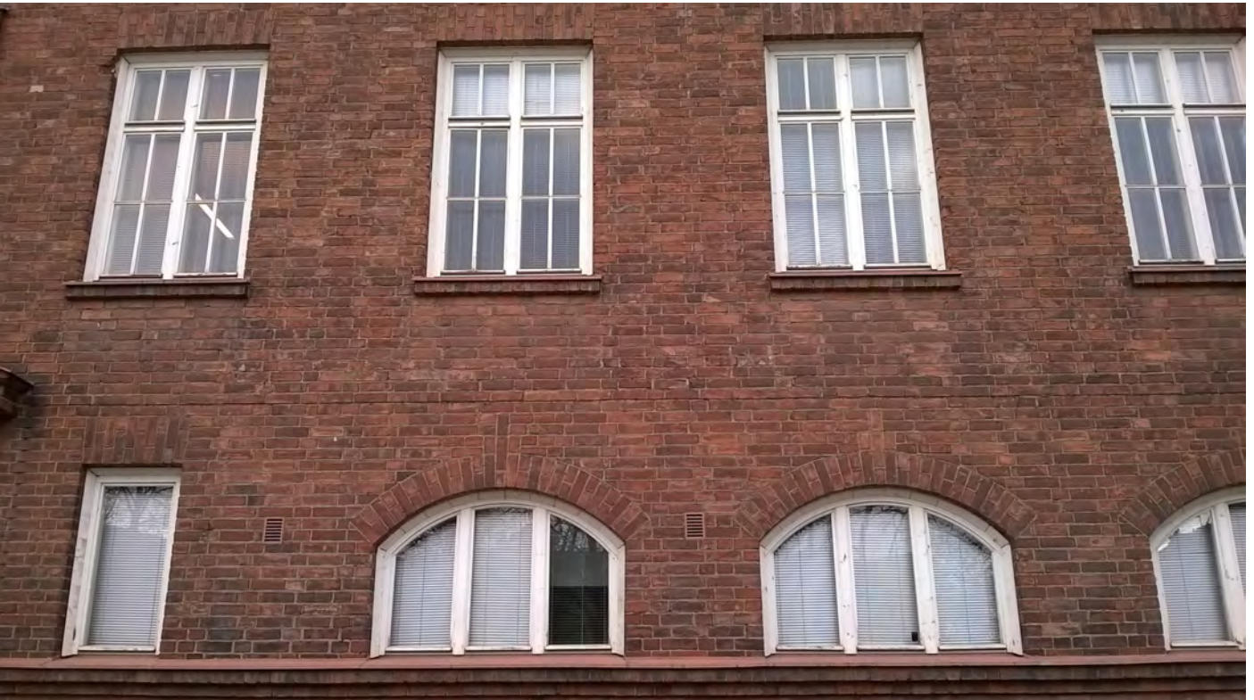
Vertaa kaari-ikkunoiden listoituksia. Uusi ja vanha tekotapa.
