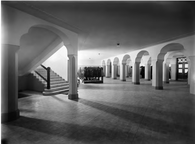
kuva 17. Näkymä 1. kerroksen sissäntulohallista. Eric Sundström 1923. Kaupunginmuseon kuva-arkisto
