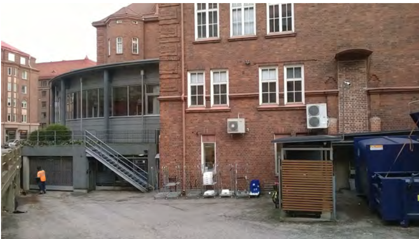
Huoltopiha jätekatoksineen. Vasemmalla parkkihallin ovet.
