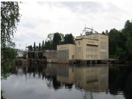
Ammäkosken voimalaitos, kuva SeppVei
