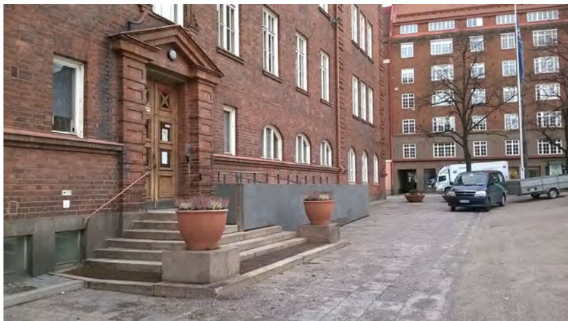
Sammonkadun puoleisen sisäänkäynnin esteetön luiska
