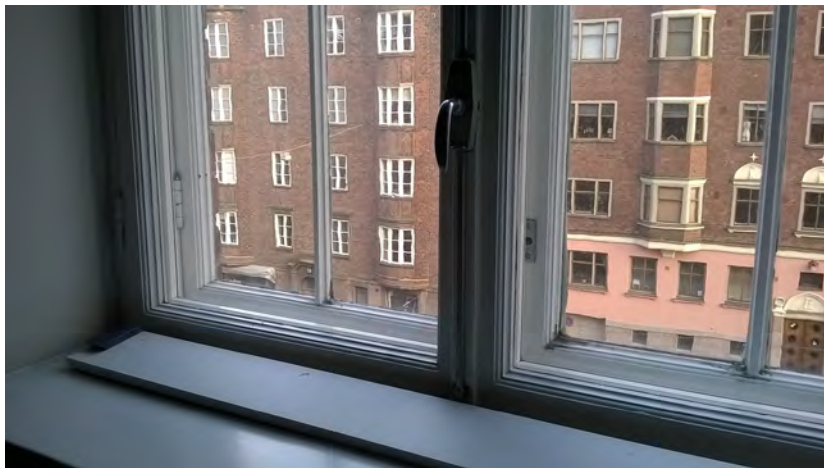
Alkuperäinen ikkuna Runebergin kadun puolella. Pääosin myös alkuperäinen heloitus.
