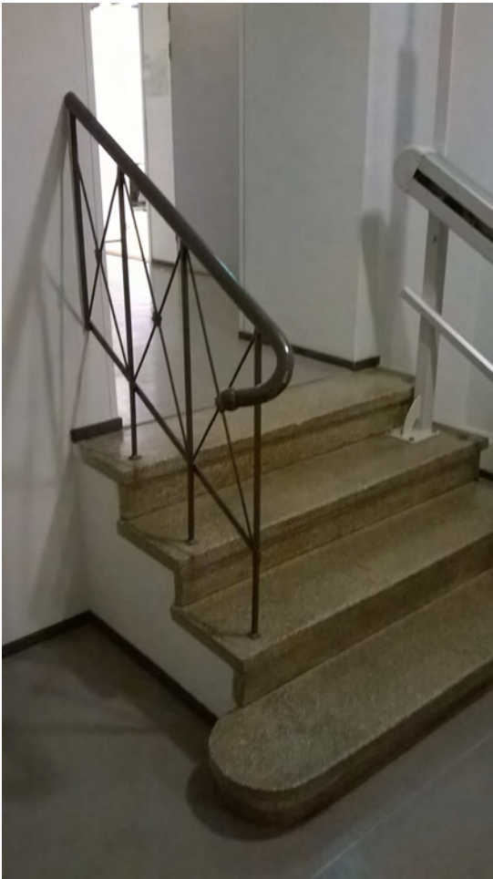
Alkuperäinen porras 1. kerroksessa. Alunperin tästä päästiin 1 krs. aulaan keittiö- ja ruokailutiloihin
