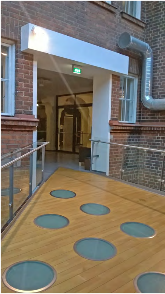
Uudesta osasta vanhan osan 1. kerrokseen johtavat sillat
