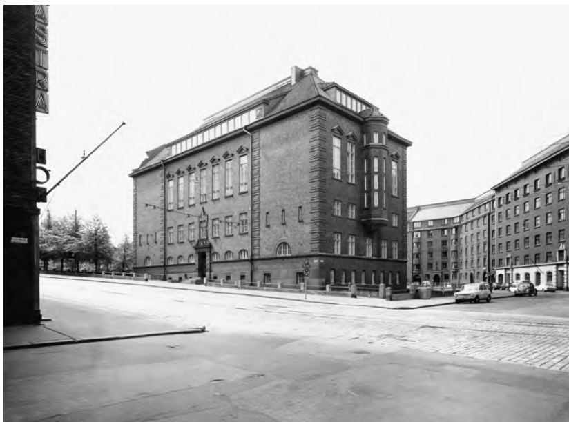
Kuvat ennen ja jälkeen Runeberginkadun julkisivun ikkunamuutosta. Rakennuksen oikeassa reunassa on nähtävissä v.1969 remontissa lisätyt ikkunat, jotka rumasti rikkovat fasadin symmetrian ja umpinaisen muuripinnan. Kuva, Arkkitehtuurimuseon kuva-arkisto sign. 40-2731, 1966
