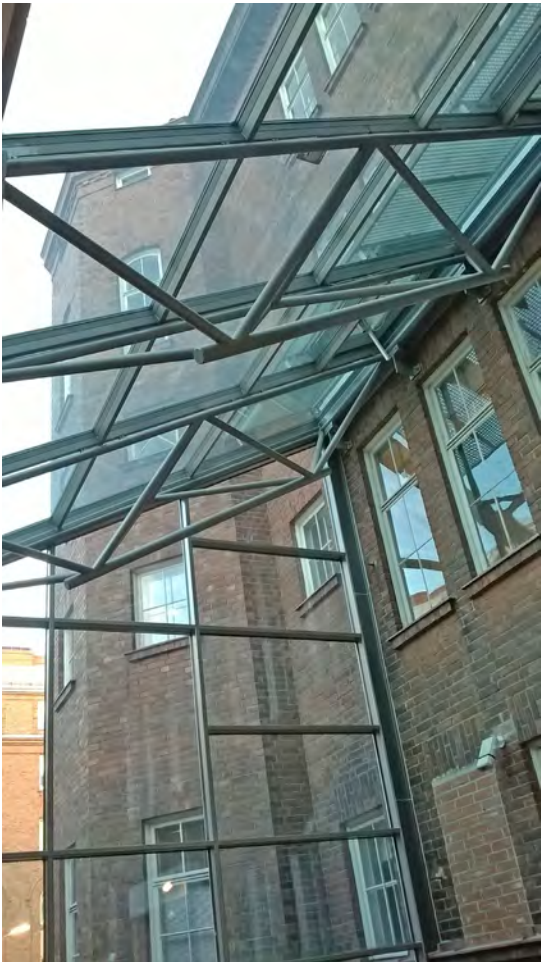
Vanhan ja uuden osan liittävät lasirakenteet
