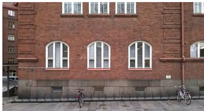
Kuva 11. Toteutetut ikkunat rakennuksen reunoilla 1.kerroksessa Sammonkadun puolella
