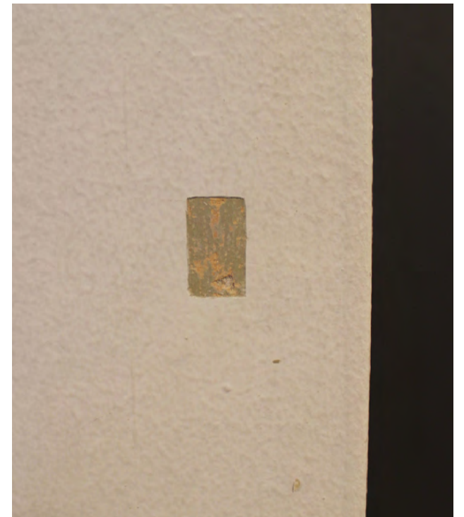
Kolmannen kerroksen aula ja aulan seinän esiinotto.
