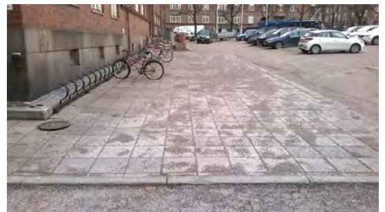
Rakennuksen puolella ovat betonilaatoitettu alue sekä seinustan kiveysalue pyörätelineineen
