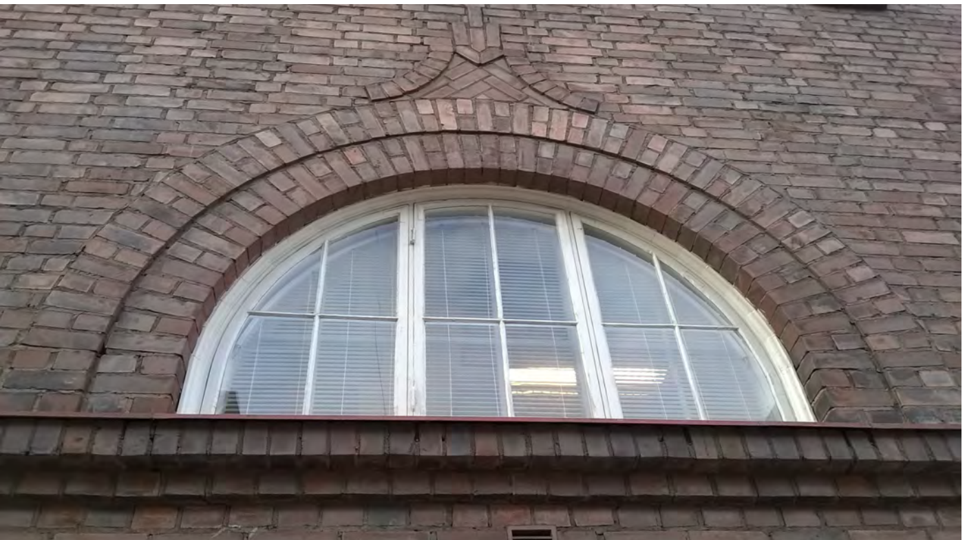
Vertaa kaari-ikkunoiden listoituksia. Uusi ja vanha tekotapa.
