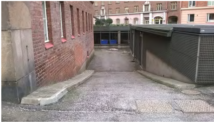
Muuntamo ja ajoluiska Runeberginkadun ja Ilmarinkadun kulmassa Runeberginkadun puoleiseen julkisivuun.
